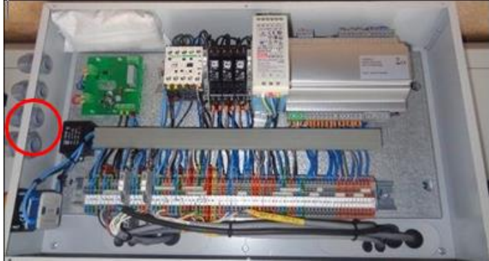
Şekil 15. E3-DSP ekran bağlantı rakorunun pano üzerinde gösterimi.
