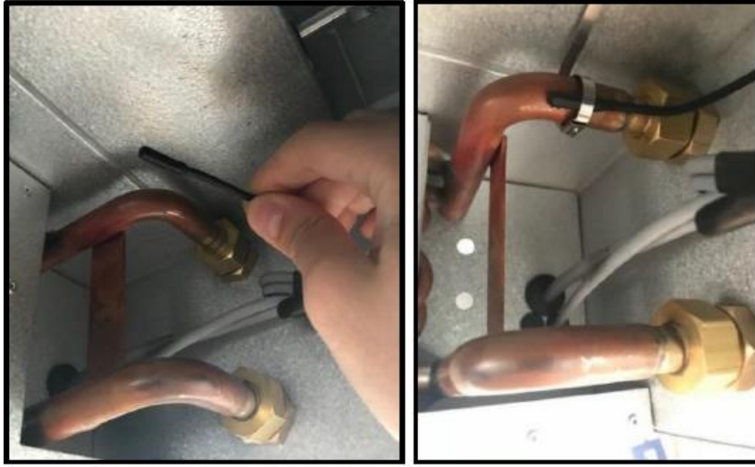
Şekil 10. Sıcaklık sensörünün sıcak su giriş borusunun üzerine bağlanması.
