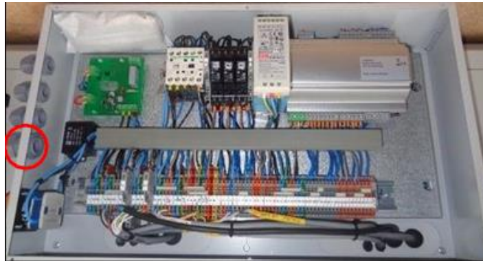
Şekil 11. Şebeke bağlantısında kullanılacak rakorun gösterimi.
