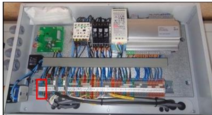
Şekil 12. Güç bağlantısı terminal giriş yerinin gösterimi.
