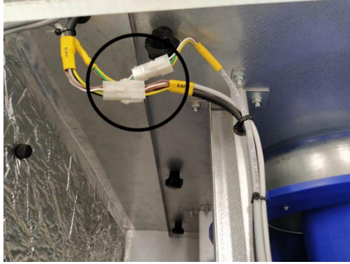
Şekil 27. Fan elektrik bağlantı yerinin cihaz içerisindeki gösterimi.
