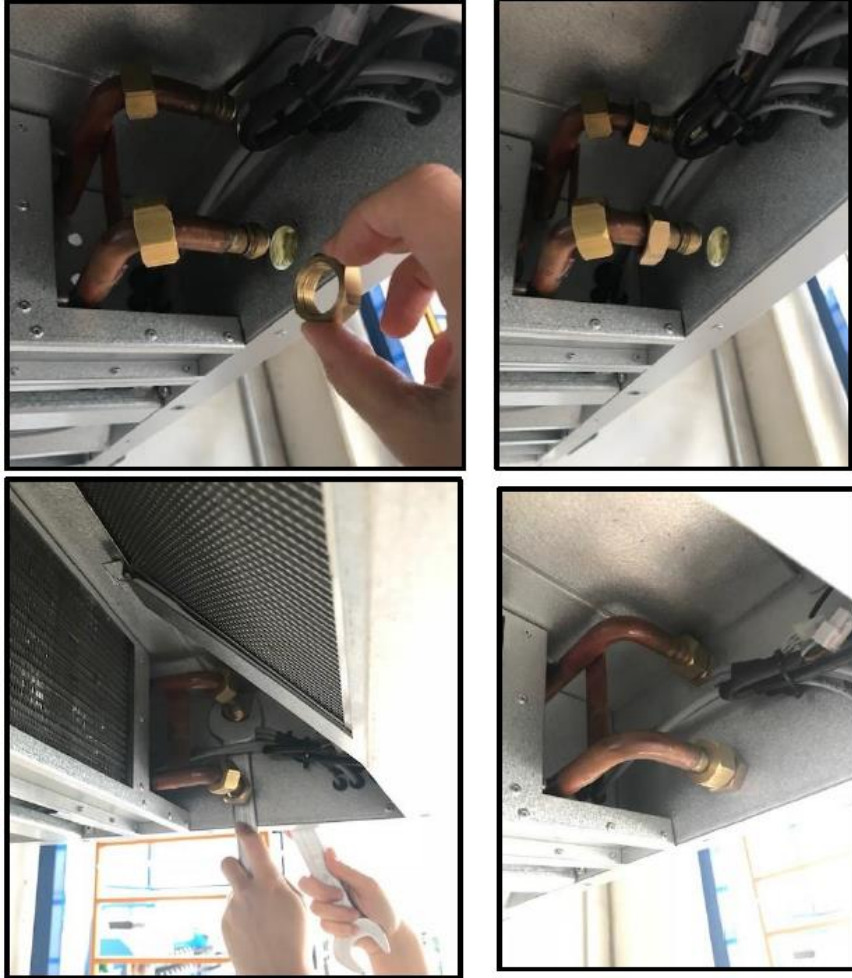
Şekil 9. Su giriş ve çıkış borularının ana hatta bağlanması.
