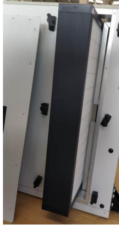
Şekil 26. Yan servis kapağında filtrenin çıkartılmış görünümü.
